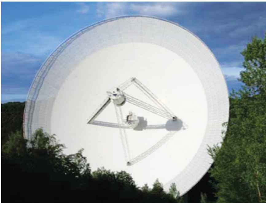
Сл. 3. Радио-телескоп пречника 100 m у близини Ефелсберга у Њемачкој (Sušić, 2014)
